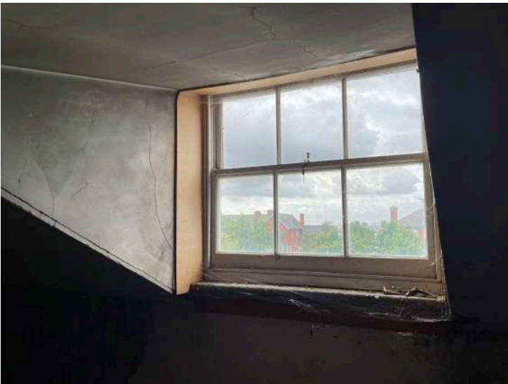
B7 - Dormer window in Storerooms (17&18)
