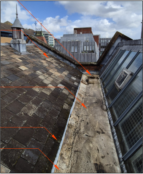
08 GUTTER RF16-VGUT.01 NTS - Date Taken: 08/10/24
