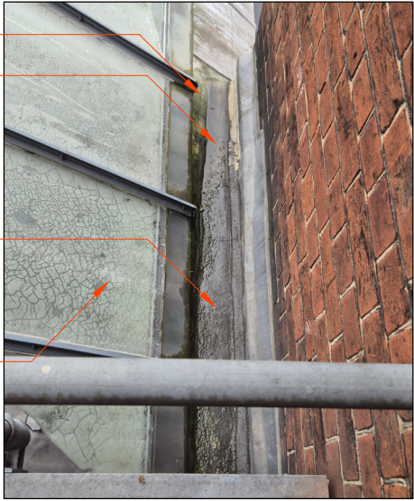
08 GUTTER RF13-VGUT.01 NTS - Date Taken: 08/10/24
