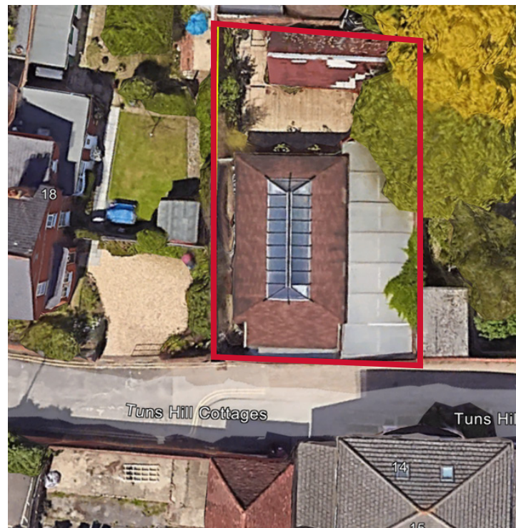
Site areal view
