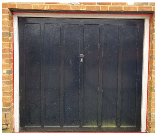
Existing garage door
