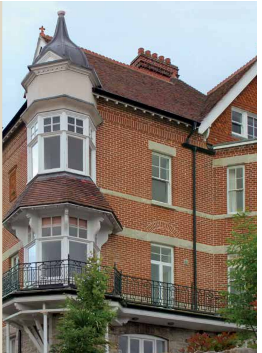
Penlu Flats, Swanage
