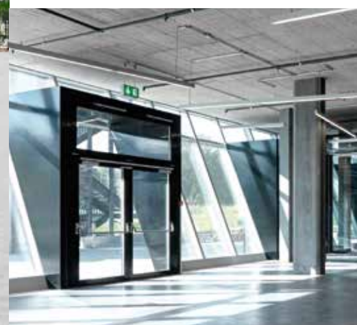
Umweltarena – Spreitenbach, CH
