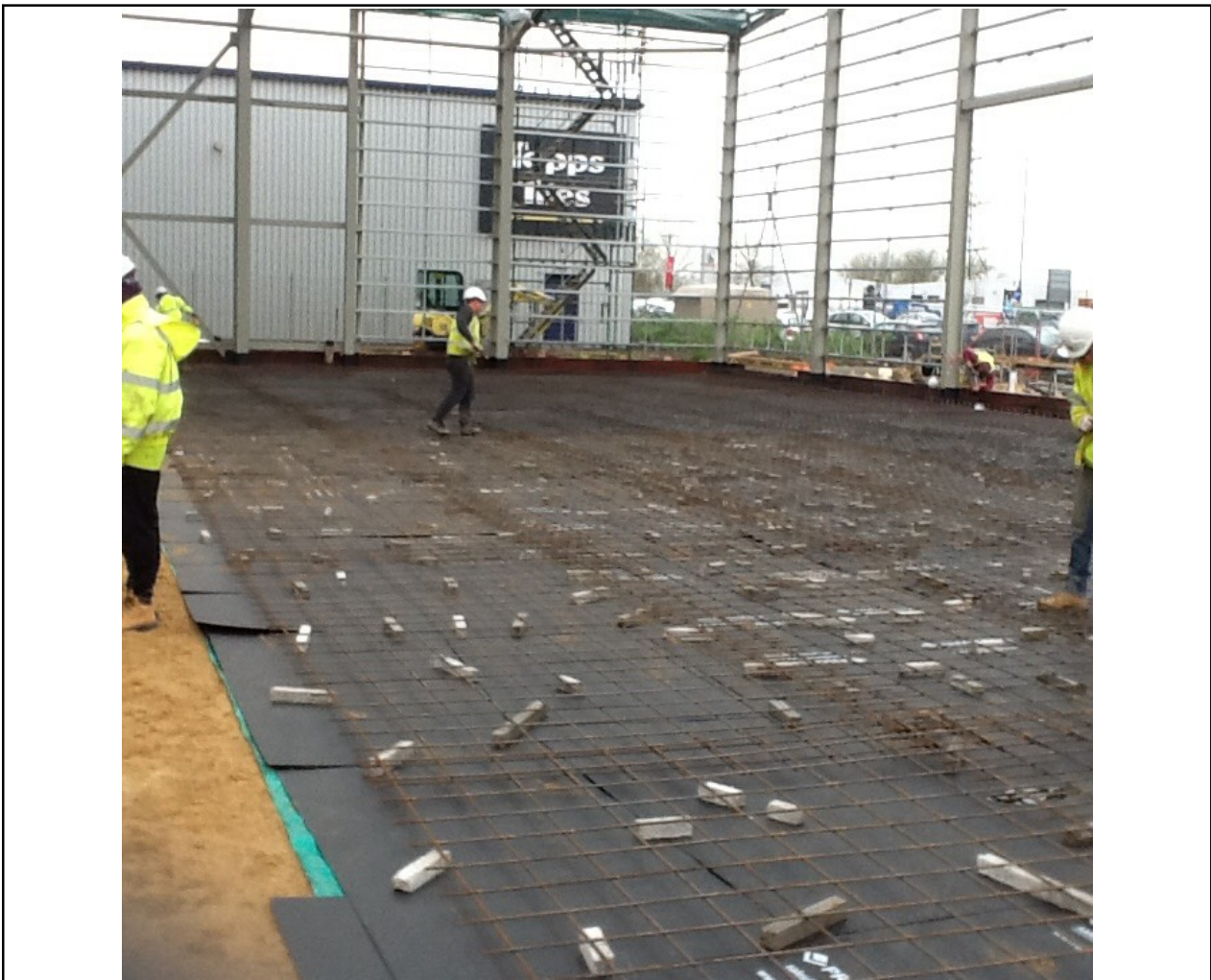
Overview premtech protection applied prior to pour
