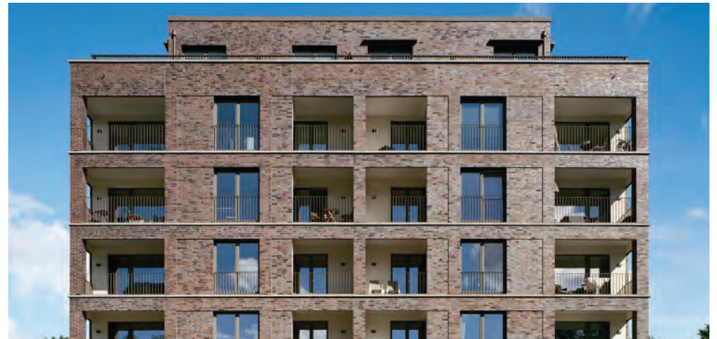
Ifflandstraße, KBNK Architekten
