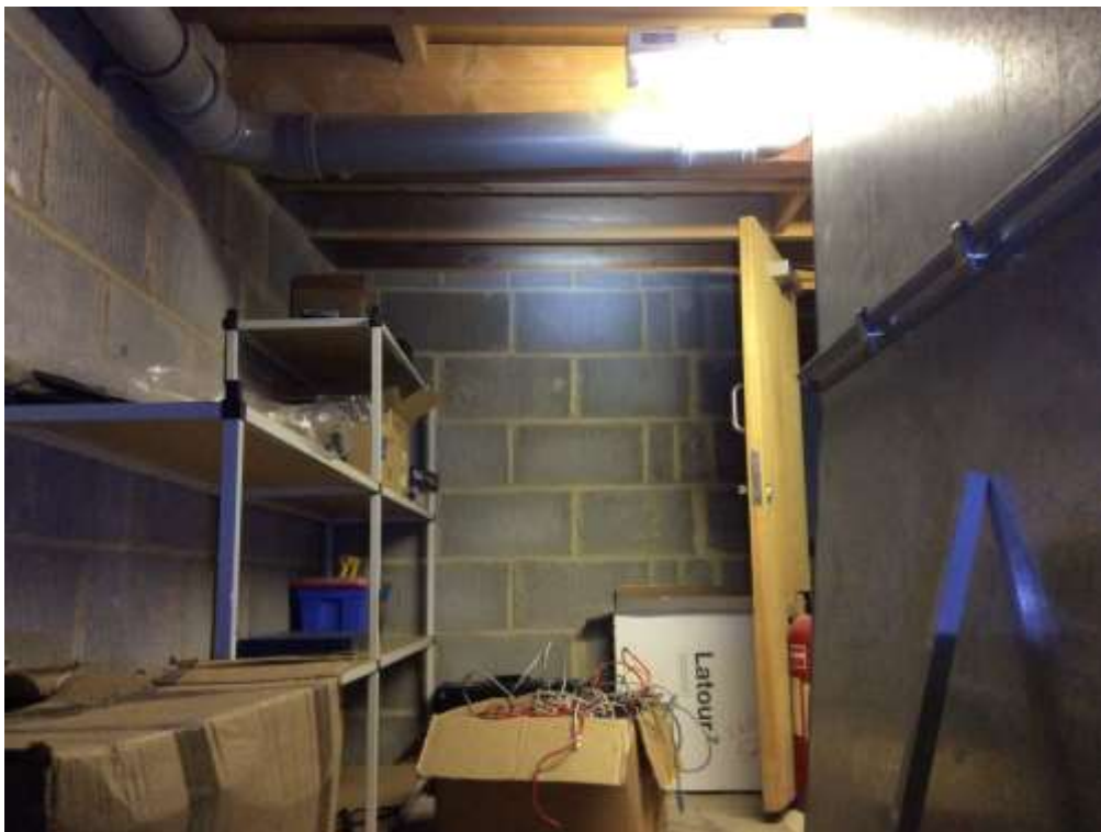
Photo 10. B56 loft space
