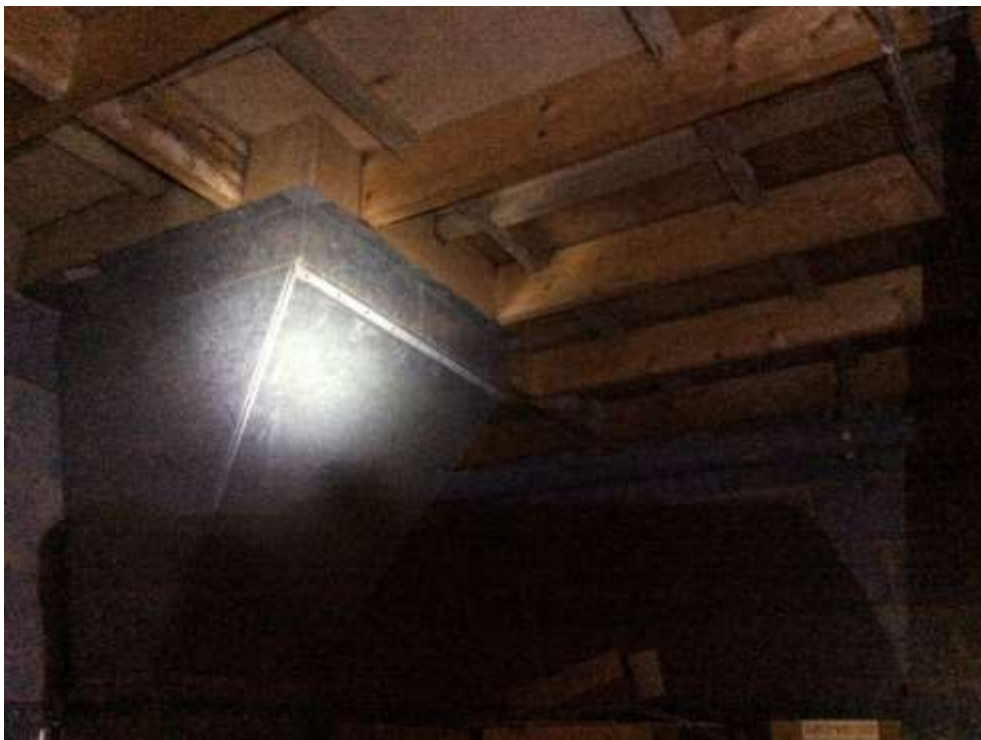
Photo 4. B58 loft space
