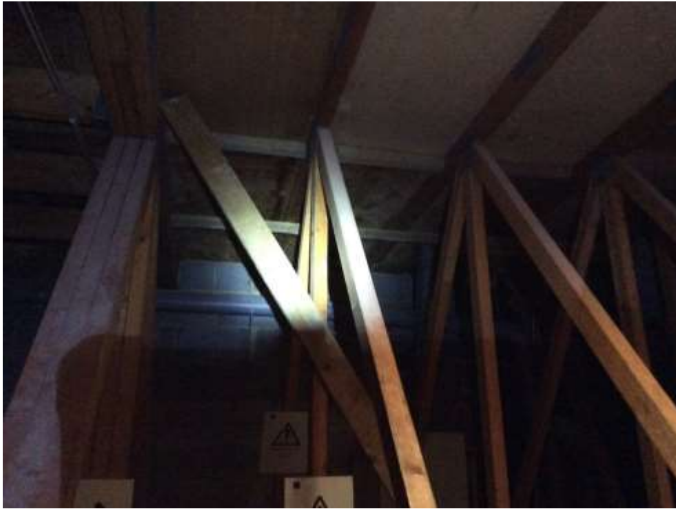
Photo 3. B58 loft space
