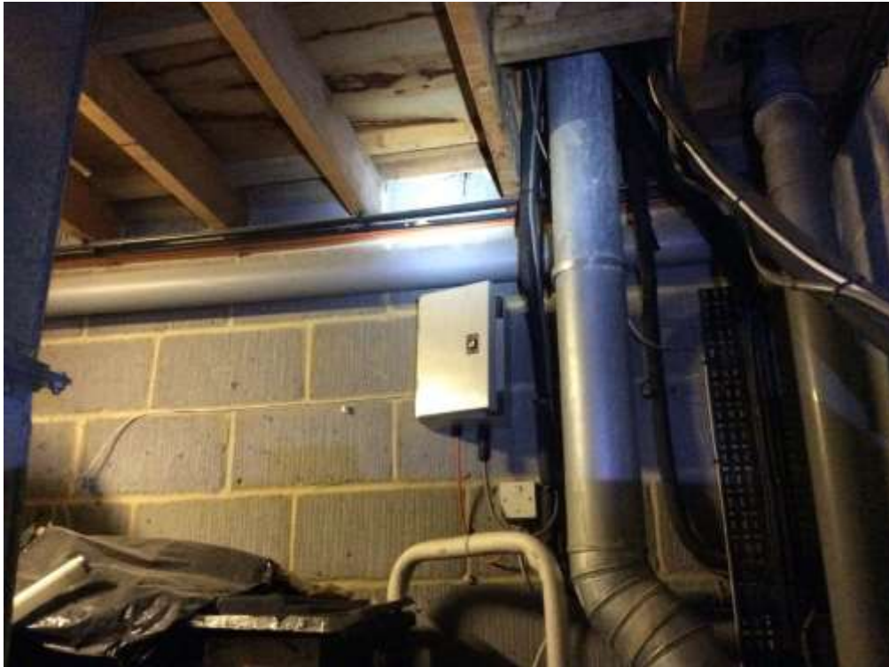
Photo 9. B56 loft space
