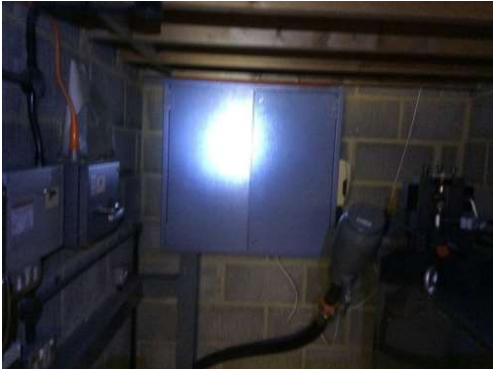
Photo 11. B56 loft space
