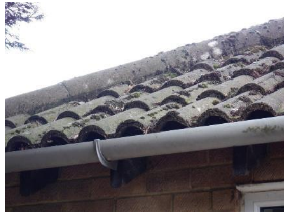
4. Intact hip mortar.
