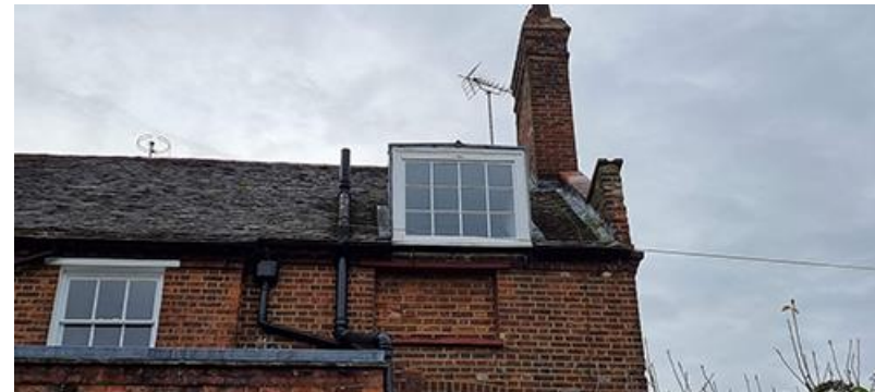
Existing mortar infill
