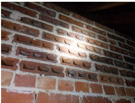
14. Party wall (roof void).
